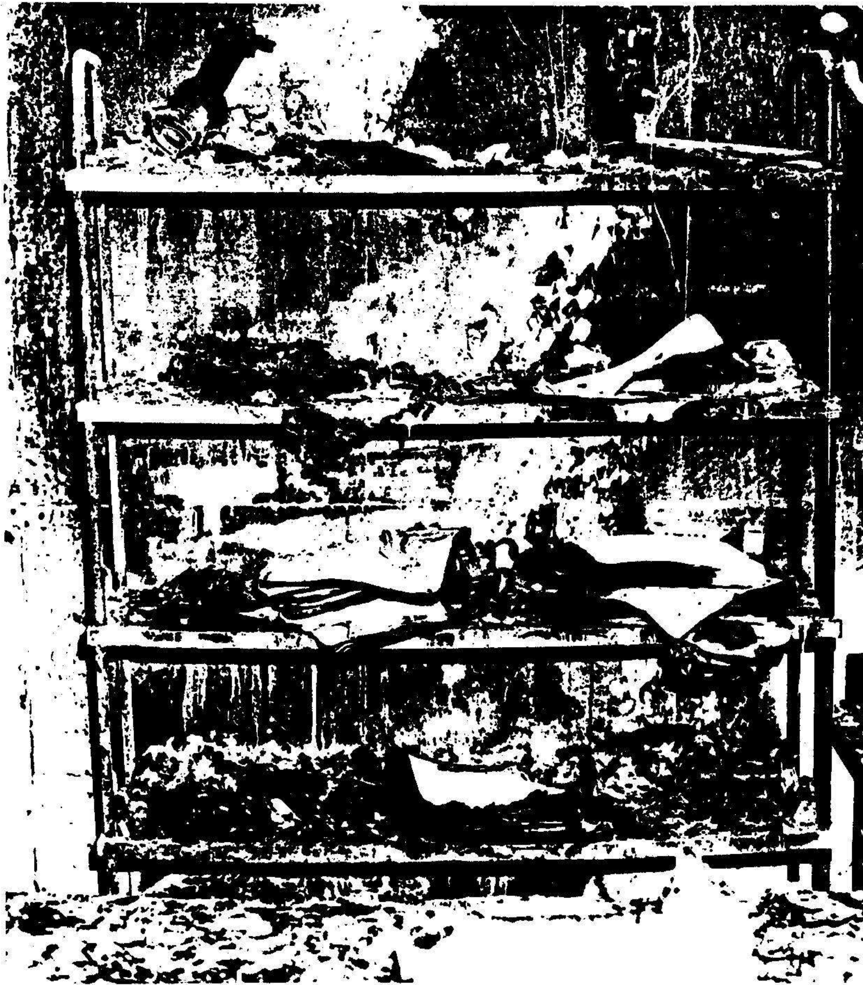
Archivraum nach dem Brand
