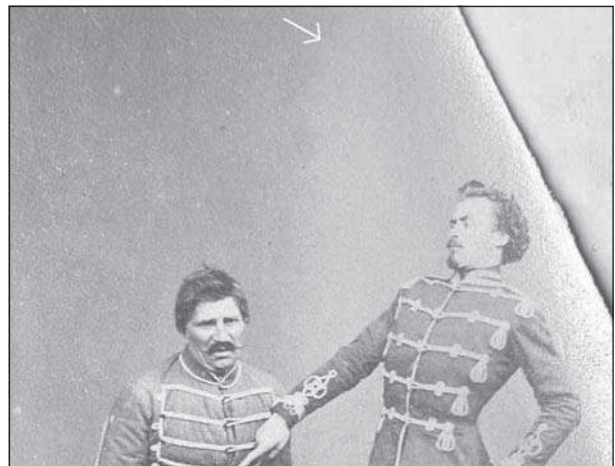
Abb. 7: Neben der charakteristischen Vergilbung der Albuminpapiere waren zusätzlich Ausbleicherscheinungen zu erkennen. Folio 3, verso.
